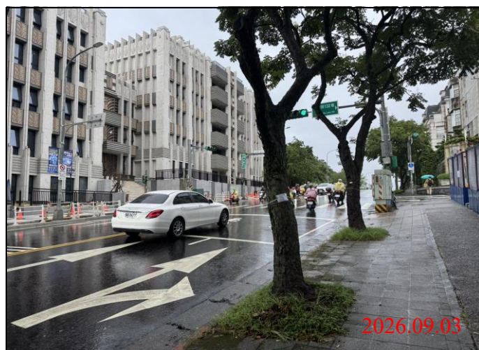
巡查日期地點：115.09.03/ Y33車站 照片說明：路面狀況
