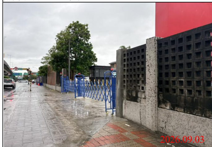
巡查日期地點：115.09.03/ Y34車站 照片說明：路面狀況
