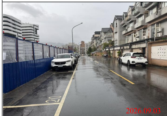
巡查日期地點：115.09.03/ Y33車站 照片說明：路面狀況
