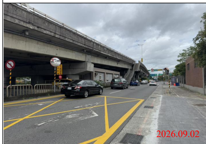
巡查日期地點：115.09.02/ Y34車站 照片說明：路面狀況
