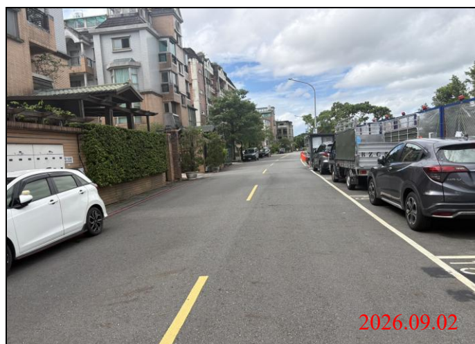
巡查日期地點：115.09.02/ Y33車站 照片說明：路面狀況
