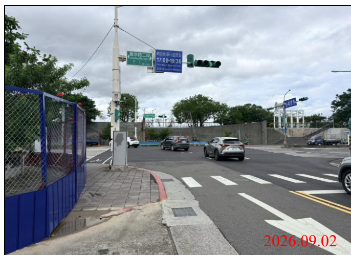
巡查日期地點：115.09.02/ Y34車站 照片說明：路面狀況
