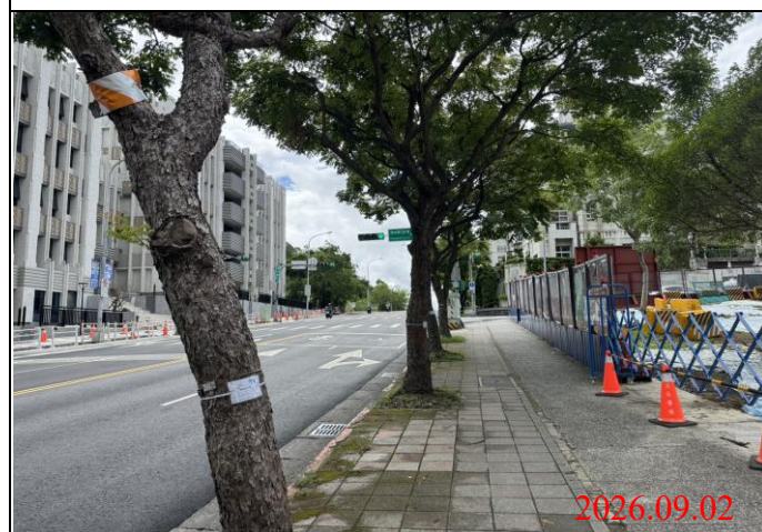
巡查日期地點：115.09.02/ Y33車站 照片說明：路面狀況
