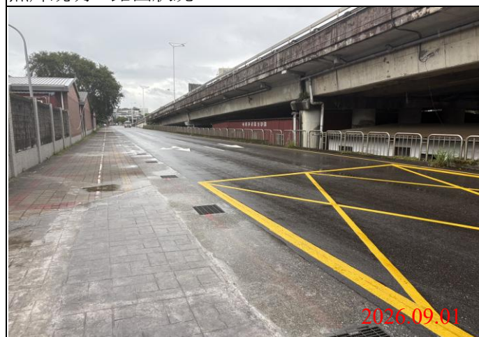
巡查日期地點：115.09.01/ Y34車站 照片說明：路面狀況
