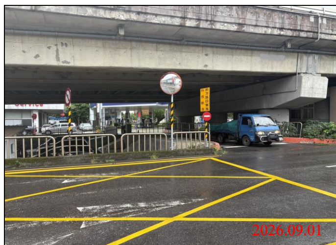
巡查日期地點：115.09.01/ Y34車站 照片說明：路面狀況
